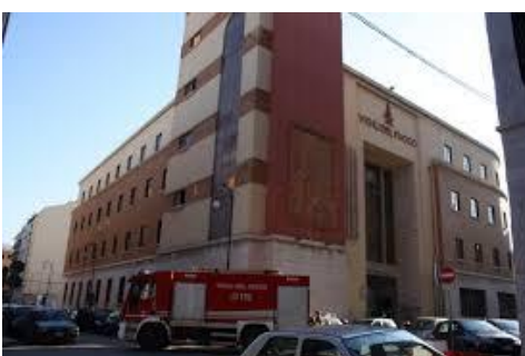
Palazzo dei Vigili del Fuoco
